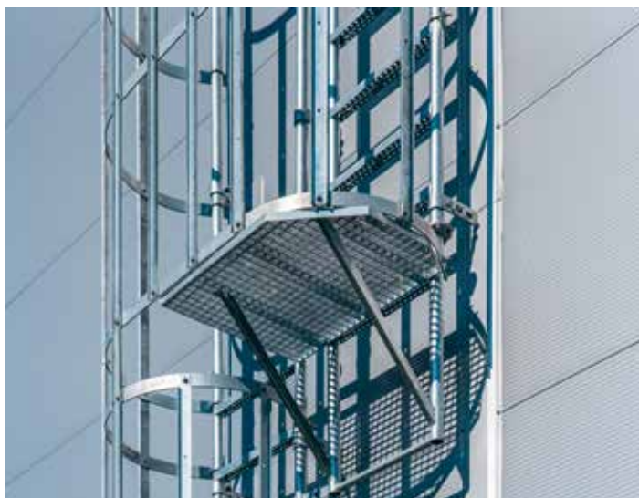
Der Rückenschutz ist allseitig angeordnet. Die verstellbaren Befestigungslaschen sind thermisch getrennt ausgeführt und durchdringen die Fassade.
