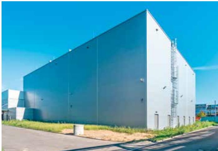
Die mehrteilige und versetzt angeordnete Steigleiter erschliesst das 14 Meter hohe Gebäude.
